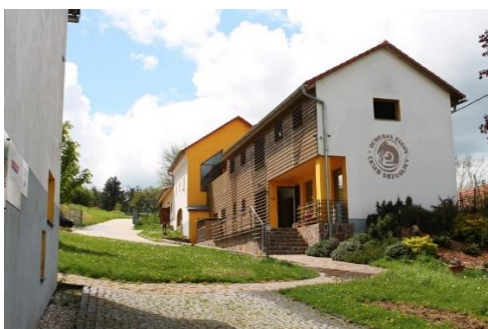
Záchranná stanice v Hrachově
